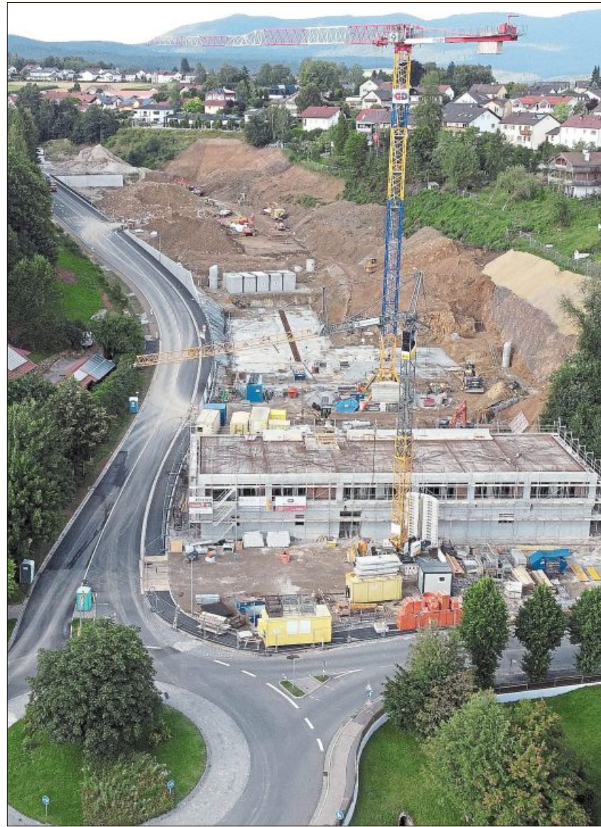
August 2021: Das Staatsstraßenstück, die Abbiegespur und der Geh- und Radweg sind fertiggestellt. Der Verkehr kann wieder rollen.
