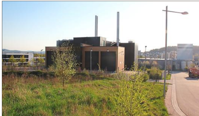
Auf der Wiese oberhalb des Biomasseheizkraftwerkes entsteht das neue Verwaltungsgebäude des Ingenieurbüros Altmann.
